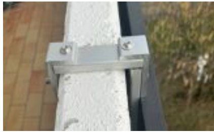
Abb 12 — Da man in den Balkon nicht reinbohren darf, sollten die Seiten des Hakens ausreichend lang sein. •
