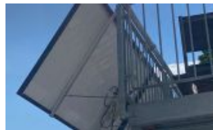
Abb 10 — Das angewinkelte Modul am Balkon. Die Aluprofilschiene wurde mit Stoppmuttern am Modulrahmen befestigt. Zusätzlich wird das Modul mit Stahlseilen gesichert. •
