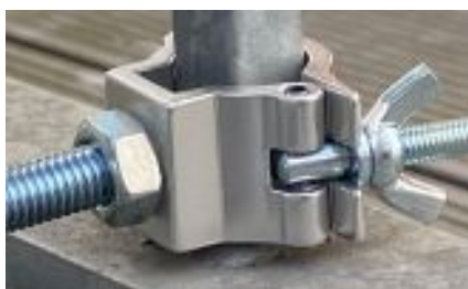
Abb 6 — Die Gewindestange für die Aufständerrung wird mit zwei Muttern an einer weiteren Halbschelle befestigt. •
